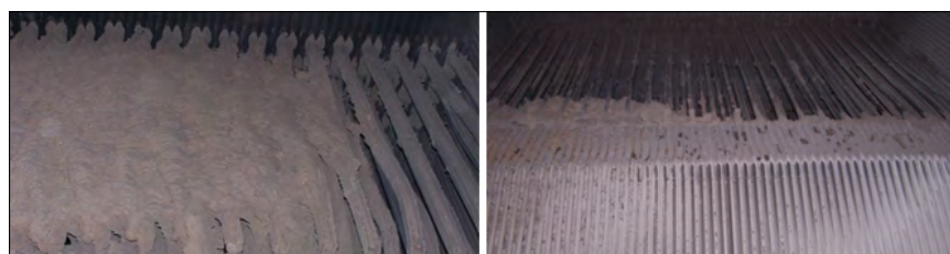
Rys. 3 A,B Widok parownika kotła biomasowego przy spalaniu biomasy Agro i zrębków (50/50) A-po lewej – bez dodatku, B – po prawej z dodatkiem haloizytu [6]
