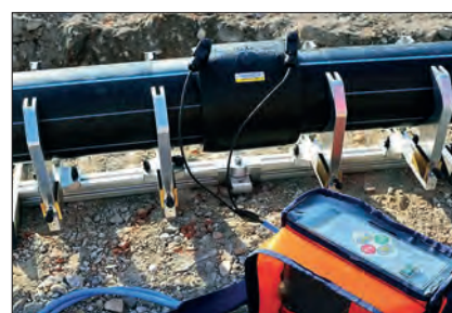
Rys. 8. Centrownik do wykonywania połączeń zgrzewanych fot. www.zabtr.ru
