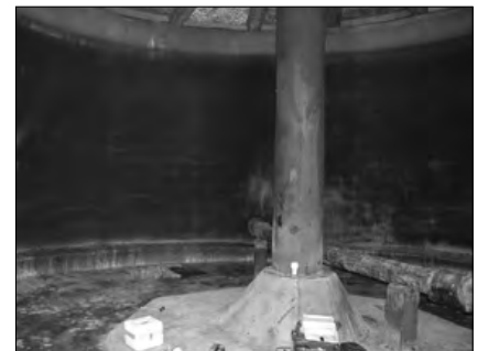
Rys. 2. Widok ogólny wnętrza zbiornika Fig. 2. General view of the inside of the tank
