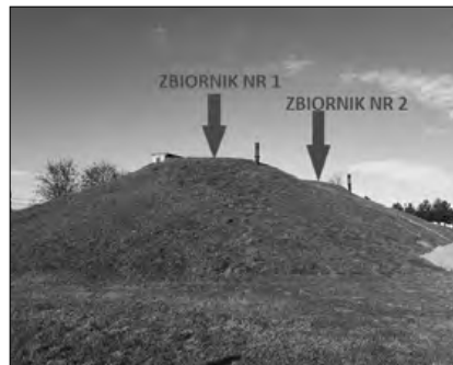
Rys. 1. Widok ogólny zbiorników Fig. 1. General view of the tanks
