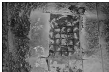
Rys. 5. Odkrywka punktowa – warstwa torkretu oraz zbrojenie Fig. 5. Point outcrop – shotcrete layer and reinforcement
