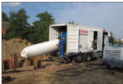
Fot.4. Wykonanie renowacji w technologii Rękawa elastycznego przez firmę Preuss Pipe Rehabilitation Sp. z o.o. (źródło: zbiory własne) Pic. 4. Renovation using Flexible Sleeve technology by the company Preuss Pipe Rehabilitation Sp. z o.o. (source: own collections)
