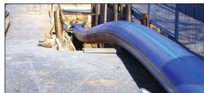
Fot. 2. Wykonanie renowacji w technologii Reliningu (źródło: Simona)
