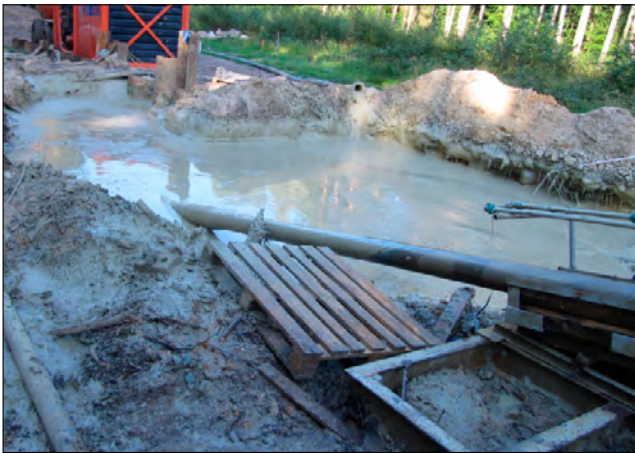
Fot. 4. I etap montażu - wiercenie pilotowe w metodzie bezwykopowej HDD Pic. 4. 1st stage of assembly - pilot drilling, the HDD trenchless method
