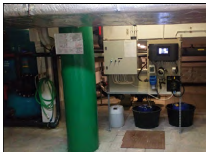
Fot. 12. Zespół pomiarowo – sterujący – dozujący
