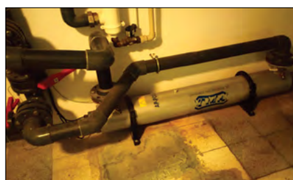
Fot. 13. Reaktor niskociśnieniowy UV w zabudowie poziomej
