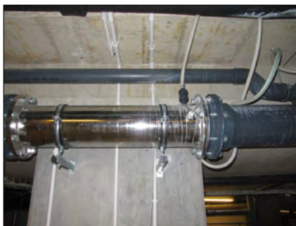
Fot. 16. Stacyjny mieszalnik rurowy ZPM
