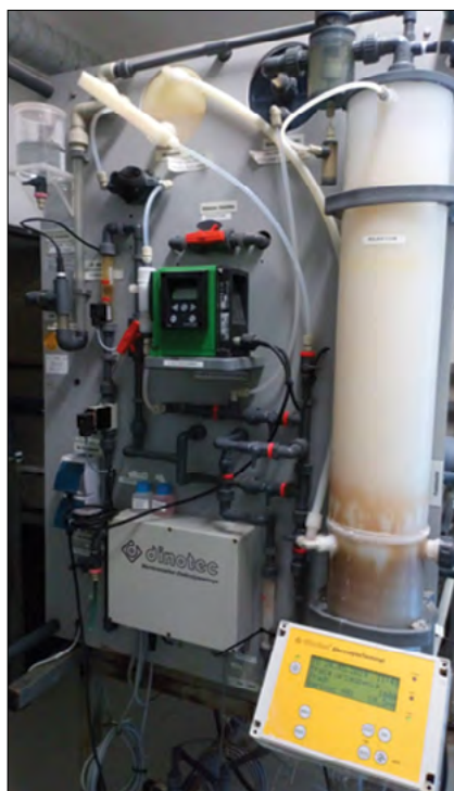
Fot. 8. Elektrolizer membranowy
