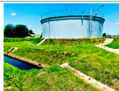
Rys. 3. Zbiornik magazynujący wody w Głubczycach
