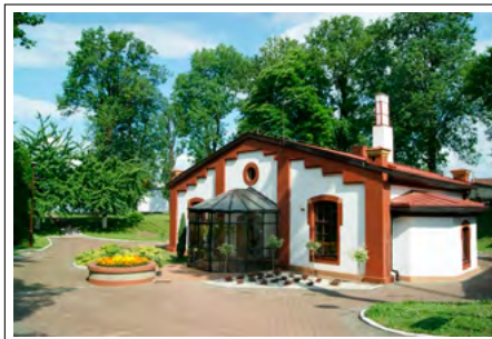
Rys. 2. Pompownia wody przy ulicy Powstańców w Głubczycach
