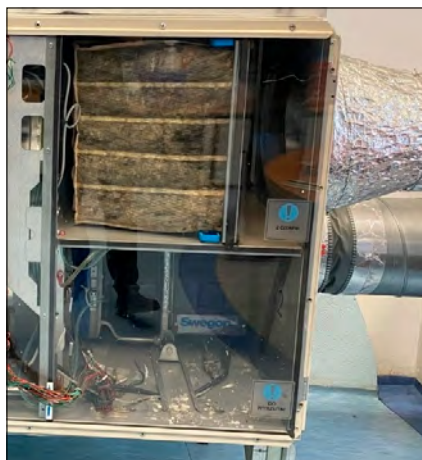
Rys. 4. Zdjęcie obrazujące centralę wentylacyjną z widocznymi odchodami ptaków, które zamieszkały w przewodzie wywiewnym. Fig. 4. Photo showing the air handling unit with visible droppings of birds living in the exhaust duct.
