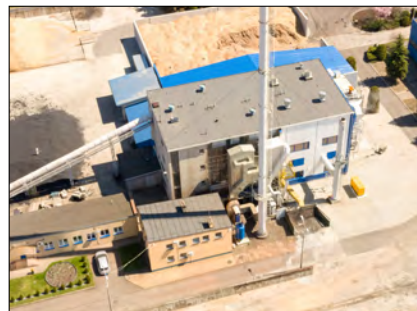
Fotografia 1. Widok z lotu ptaka na kotłownię biomasową wraz z placem opałowym. Photo 1. Bird's eye view of the biomass boiler house with the fuel yard
