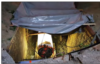
Fot.3. Wykładzina SearTex – Liner H 2 O w trakcie utwardzania lampami UV Pic.3. SearTex liner – Liner H 2 O during curing with UV lamps
