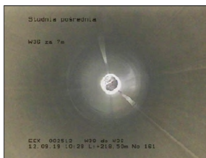
Fot.7. Inspekcja CCTV rurociągu DN500 z żeliwa szarego – stan po renowacji wykładziną CIPP UV Pic. 7. CCTV inspection of gray cast iron pipeline DN500 – condition after renovation with CIPP UV lining
