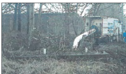
Fot. 11. Instalacja rękawa Pic. 11. Sleeve installation
