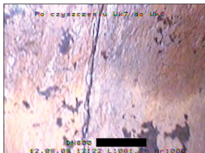
Fot.16. Spaw połączeniowy rur stalowych Pic.16. Welded connection of steel pipes
