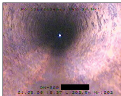
Fot.20. Wnętrze rurociągu DN600 przed procesem renowacji cementowaniem Pic. 20. The interior of the DN600 pipeline before the renovation process
