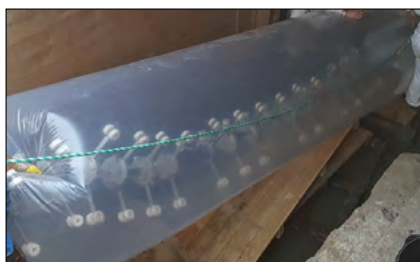
Fot.2: Wprowadzanie łańcucha z lampami UV w celu utwardzenia wykładziny SearTex – Liner H 2 O Pic. 2: Inserting a chain with UV lamps to harden SearTex-Liner H 2 O
