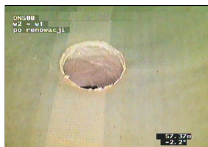
Fot. 15. Odgańlenie otwarte poprzez frezowanie Pic. 15. Open branch by milling mounting on the kink of the pipeline
