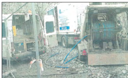
Fot. 9. Przygotowanie do procesu czyszczenia w miejscu wykopu technologicznego Pic. 9. Preparation for the cleaning process at the technological excavation site
