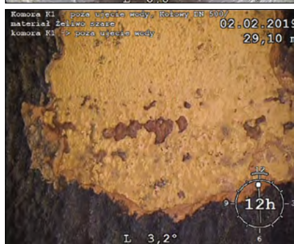
Fot.5. Inspekcja CCTV rurociągu DN500 z żeliwa szarego – stan przed renowacją i czyszczeniem – uszkodzenie ścianki wewnętrznej Pic. 5. CCTV inspection of gray cast iron pipeline DN500 – condition before renovation and cleaning. Damage to the inner wall
