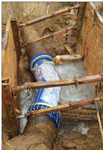
Fot.4. Rurociąg na załamaniu 30°. Stan po renowacji Pic. 4. Pipeline at a 30 ° bend. Condition after renovation
