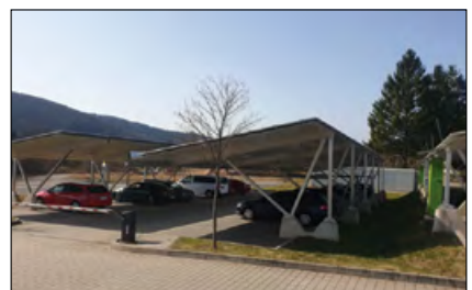
Rys. 9. Wiaty parkingowe ze zintegrowaną instalacją fotowoltaiczną, fot. K. Kurtz-Orecka Fig. 9. Parking shelters with integrated photovoltaic installation, photo by K. Kurtz-Orecka
