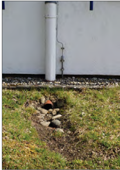
Rys. 11. System odprowadzenia na teren biologicznie czynny wód opadowych z dachów, fot. K. Kurtz-Orecka Fig. 11. System of drainage of rainwater from roofs to the biologically active area, photo by K. Kurtz-Orecka
