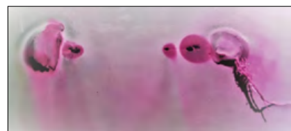
Fig. 9. Stainless steel pipeline surface after spacer removal and application of a penetrant test. Pits were located under the spacer in the line within the crevice Rys. 9. Powierzchnia rurociągu ze stali nierdzewnej po usunięciu elementu dystansowego i zastosowaniu preparatu penetrującego. Wżery powstały w szczelinie pod elementem dystansowym
