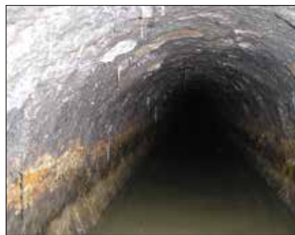
Rys.4. Wnętrze kanału żelbetowego o średnicy 800 mm [14]
