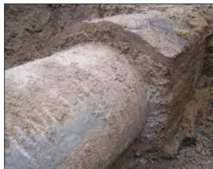
Rys.5. Kanał po odkopaniu i usunięciu betonowej obudowy w przedniej części zdjęcia [14]
