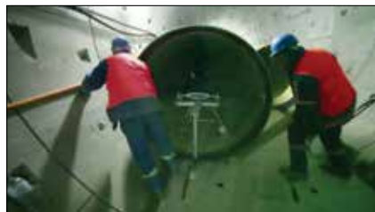
Rys.3. Przesuwanie rur GRP po płycie betonowej [18] Fig.3. Moving GRP pipes on the concrete plate [18]
