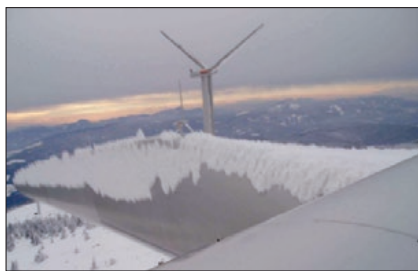
Rys. 2. Oblodzona łopata turbiny wiatrowej [26]
