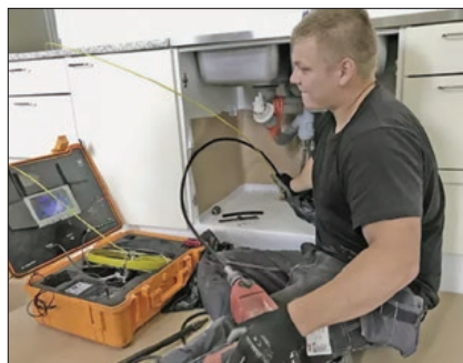
Rys. 5. Kontrola przebiegu procesu renowacji pionów kanalizacyjnych metodą natryskową [4]
