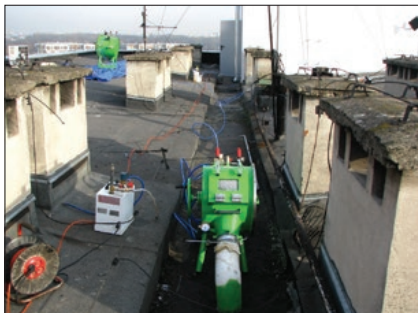
Rys. 8. Wprowadzanie rękawa odbywało się z dachu budynku [10]
