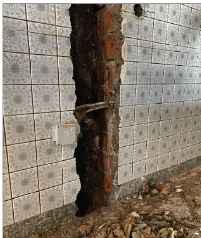
Rys. 2. Zdeponowane fragmenty wykutych rur żeliwnych [1]
