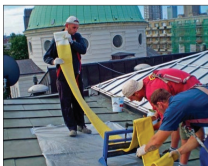
Rys. 6. Prace przygotowawcze na dachu Zachęty [5]
