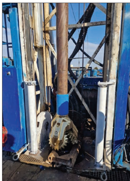
Rys. 6. Widok świdra gryzowego zamontowanego na przewodzie wiertniczym Fig. 6. View of the grit auger mounted on the drill pipe
