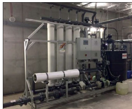
Figure 2. The single stage ultrafiltration (UF) in tested facility (fot. Anna Mika-Shalyha) Rysunek 2. Ultrafiltracja jednostopniowa (UF) w badanym obiekcie (fot. Anna Mika-Shalyha)
