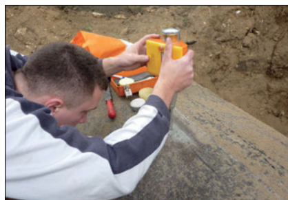
Rys.10. Nieniszczące badanie sklerometryczne jakości betonu w rurach z betonu sprężonego (zdjęcie własne) Fig. 10. Non-destructive sclerometric testing of concrete quality in prestressed concrete pipes (own photo)
