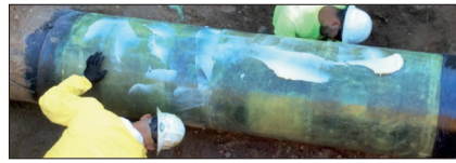
Fot. 1. Instalacja powłoki QuakeWrap™ od strony zewnętrznej [32]
